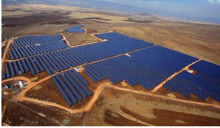
Şekil 8. Solentegre Güneş Enerji Santrali
