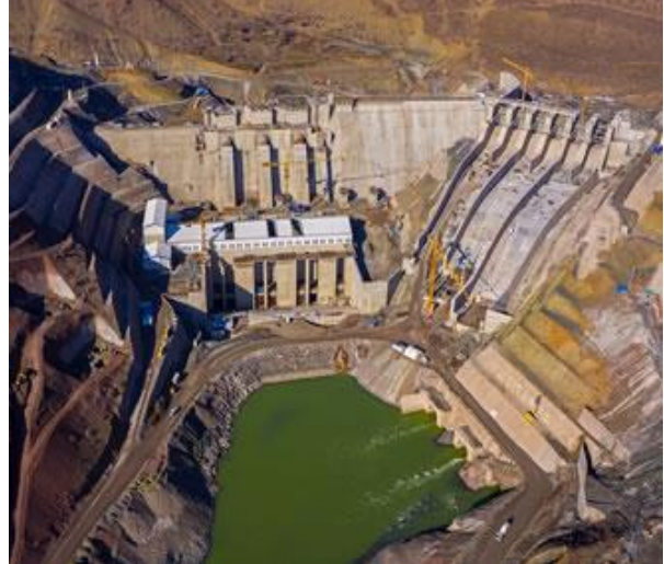
Şekil 2. Beyhan Barajı ve Hidroelektrik Santrali
