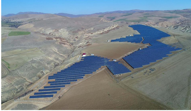
Şekil 7. Elazığ Kovancılar güneş enerjisi santrali
