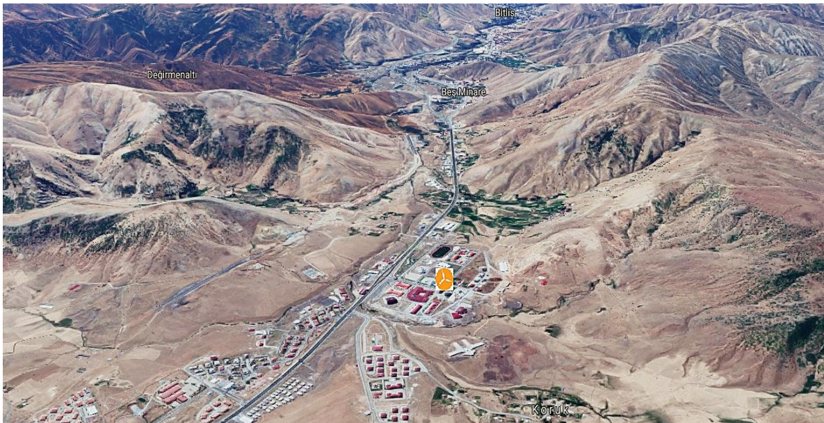
Şekil 5. Kampüs alanındaki rüzgâr ölçüm istasyonu kurulum yeri
