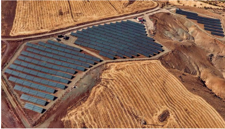
Şekil 9. Elazığ Güneş Enerji Santrali
