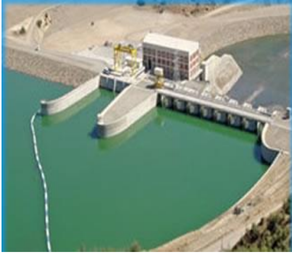
Şekil 5. Seyrantepe Hidroelektrik Santrali
