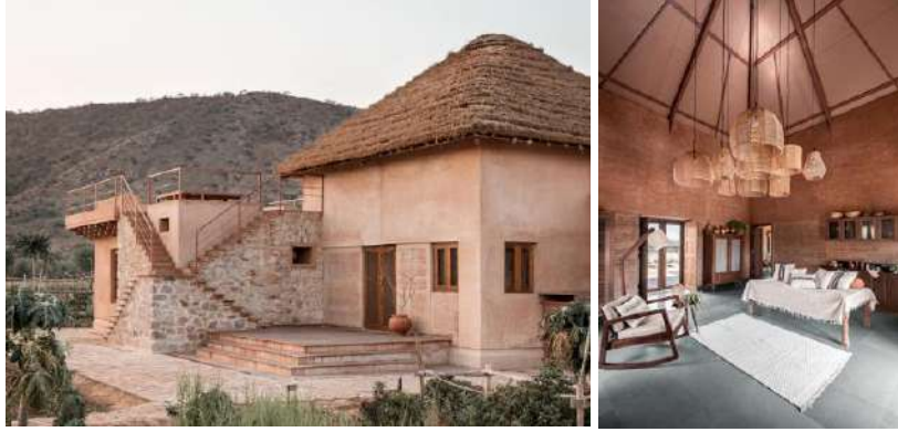
Şekil 10 : Mud House yapısı (Web 2)
