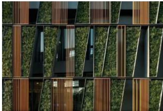
Şekil 8. Vertical Living Gallery yapısı cephe fotoğrafı (Url 1).
