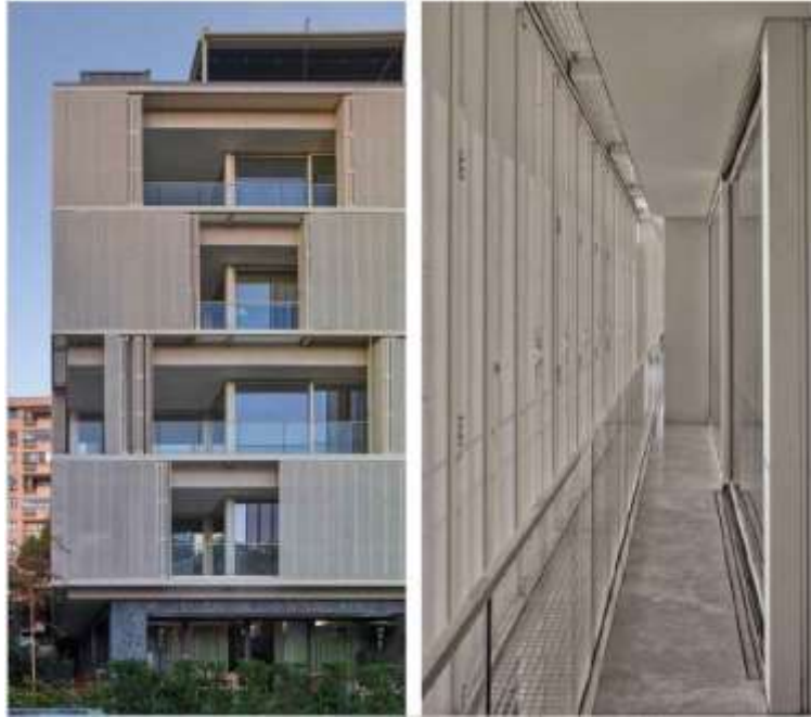
Şekil 11. Güral Suadiye Rezidans cephe sistemi (URL-10).
