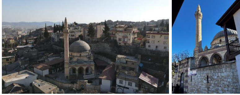
Şekil 18. Onikişubat Acemli (İskenderpaşa) Camii ve minaresine ait görüntüler
