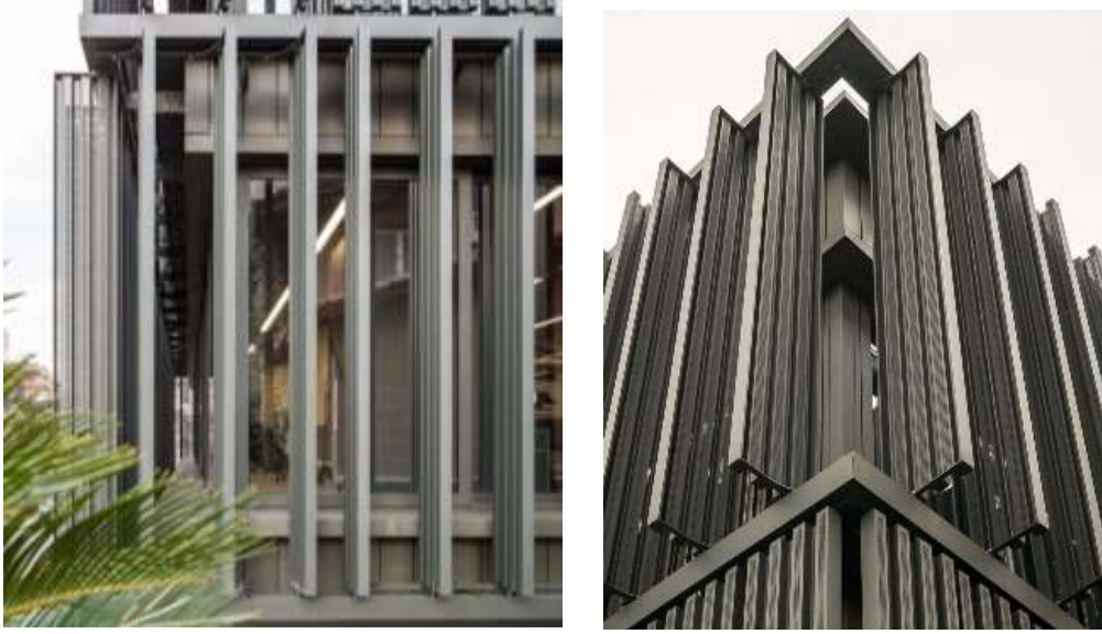
Şekil 10. Protel Yönetim Binası cephe sistemi (URL-9).
