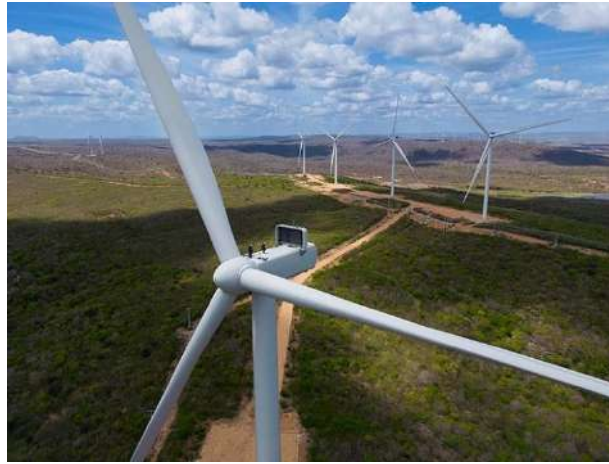
Şekil 6.6. Vestas V136-4.2 MW Rüzgar Türbini [38]
